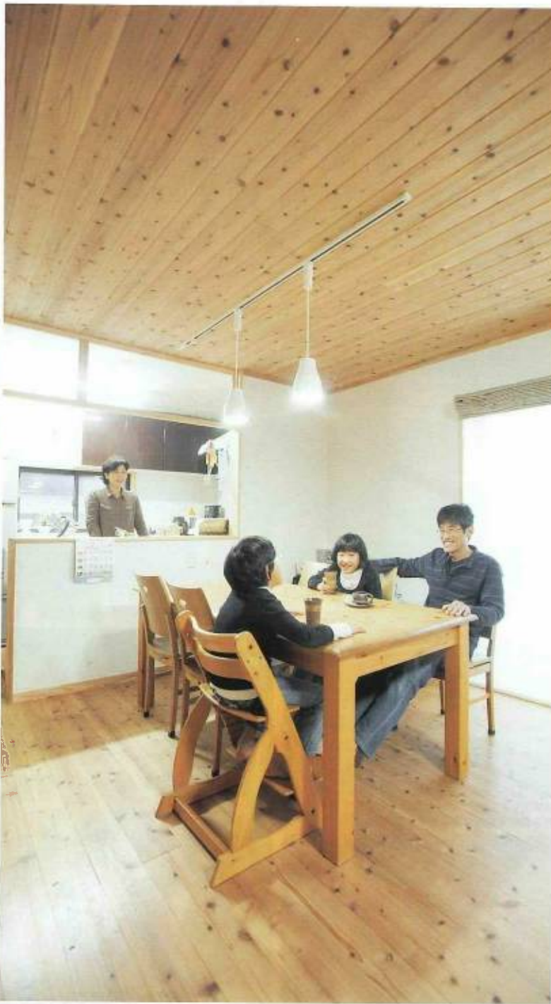
床と天井は杉の無垢材、壁は珪藻土を用いた、自然素材でできた家。「今年の猛暑もエアコンなしで乗り切れました。雨の降る日に窓を閉め切っても扇風機で大丈夫でした」とエアバス効果を実感したそうだ
