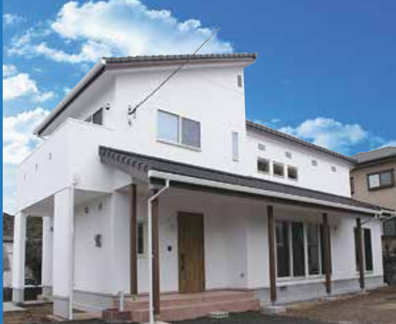
※写真は全て施工例です。
